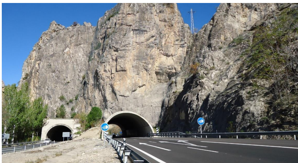
A-44. Túneles de Santa Lucía
