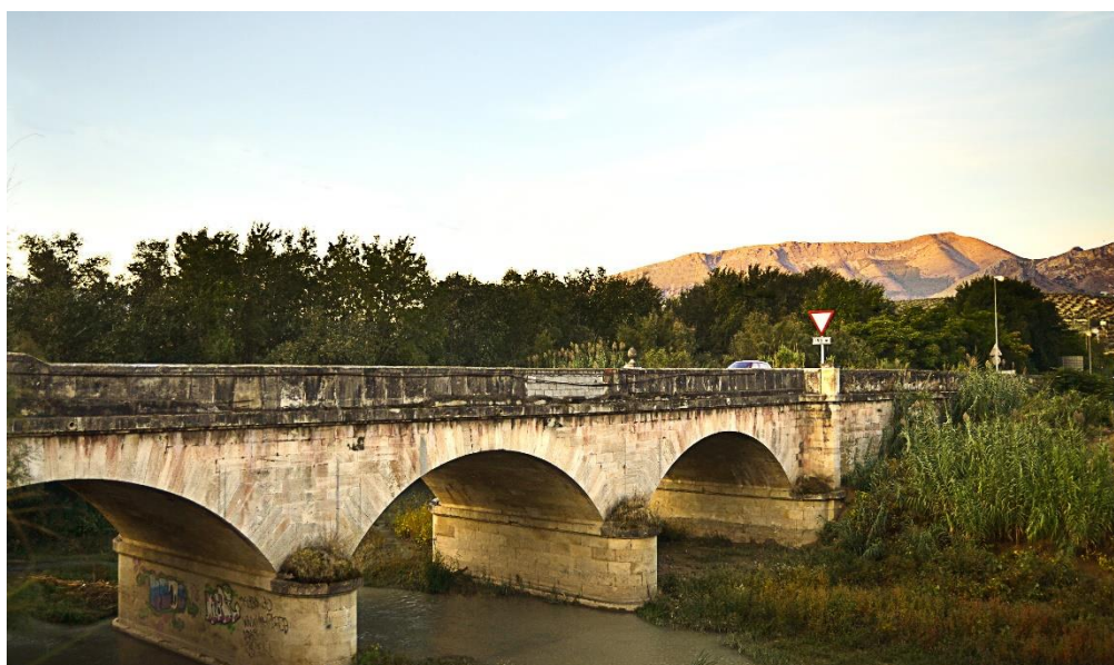
N-323. Puente sobre el río Jaén
